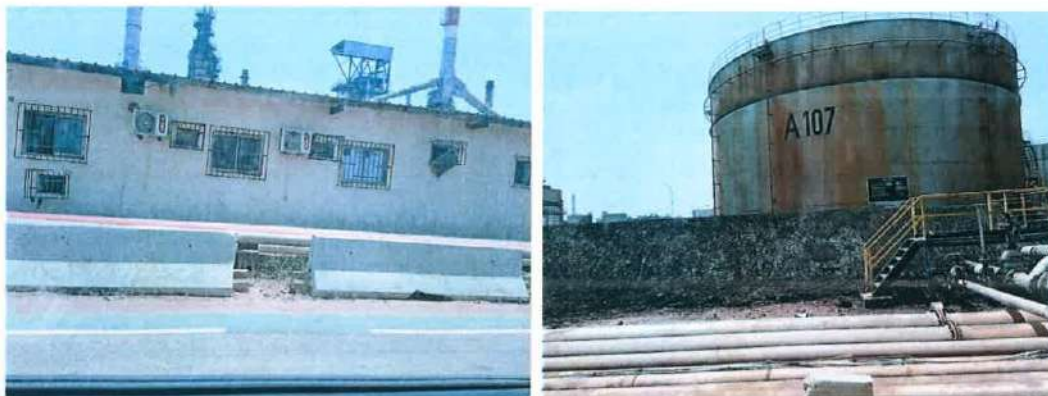
Figure : bâtis à démolir (intérieur de la SIR, ANDE mars 2021)
