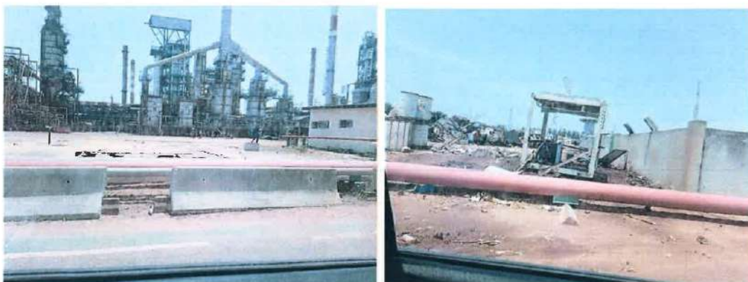
Figure 1 : site à aménager (intérieur de la SIR, ANDE mars 2021)
