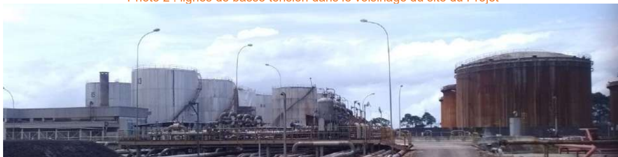
Photo 2 : lignes de basse tension dans le voisinage du site du Projet
